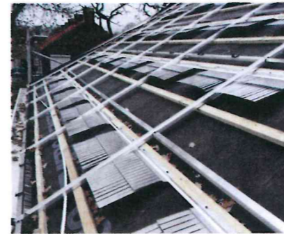
△ Het systeem maakt gebruik van de warmte van de pannen en draagt dit af aan een ringleiding.
